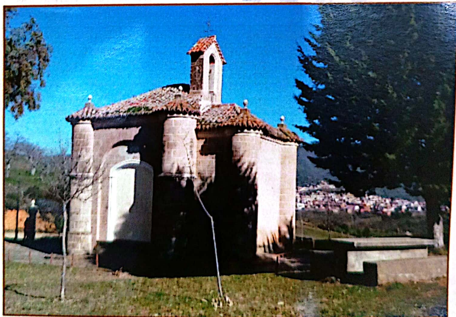
Vista general de la ermita.
