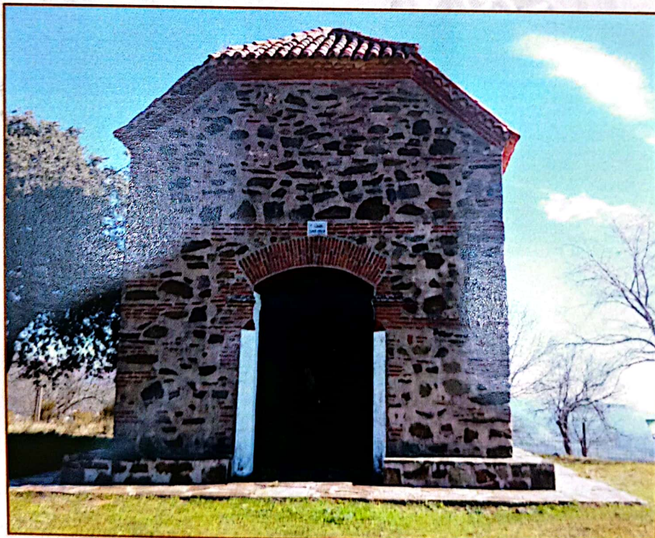
Fachada principal de la ermita.
